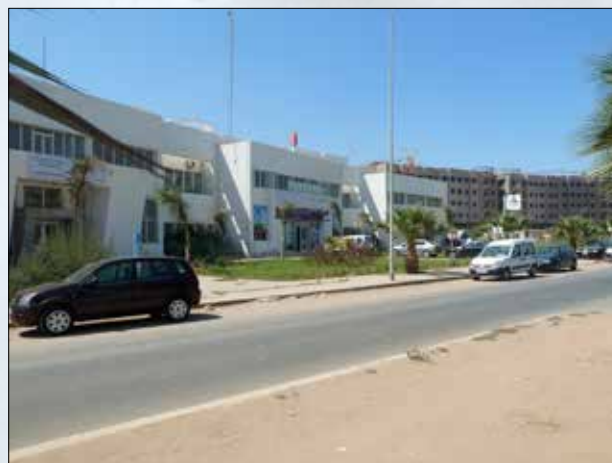
Photo 32. Les bureaux d'Al Omrane sur le site
