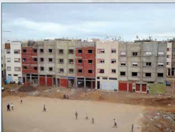
Photos 35 et 36. Etape 1 : Généralisation des locaux commerciaux non autorisés à Essalam
