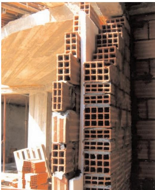
Figure 6 : Photo d'un mur extérieur montrant une double cloison de 0.35 m composée d'une brique 8 trous coté extérieur et d'une brique 12 trous côté intérieur posées à plat et séparées par des plaques de polystyrène isolantes. L'inversion des briques et la pose d'un isolant permettent de réduire les échanges thermiques entre l'intérieur et l'extérieur
