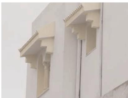
Figure 8 : Brises-soleil assurant en été un ombrage des fenêtres orientées au sud
