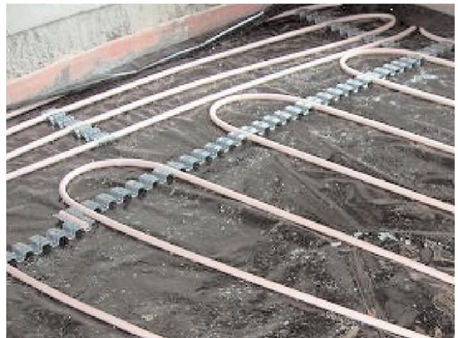
Figure 5 : Tuyauteries de chauffage au sol à basse température
