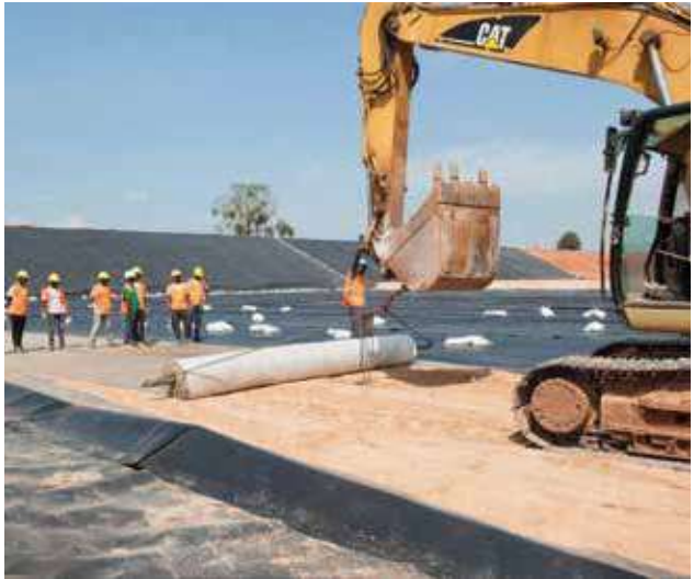
Figura 33: Representantes de la entidad contratante local visitan la obra de construcción del CRS del Gran Lomé, Togo. Crédito: COVED, cedidos por Alexandra Monteiro
