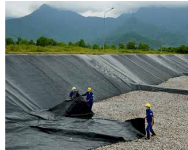
Figura 16: instalación de la lona impermeable sobre le nouveau casier del centro de relleno sanitario de Lọc Thủy, Lăng Cô, Vietnam. Crédito: Laurent Weyl/Collectif Argos
