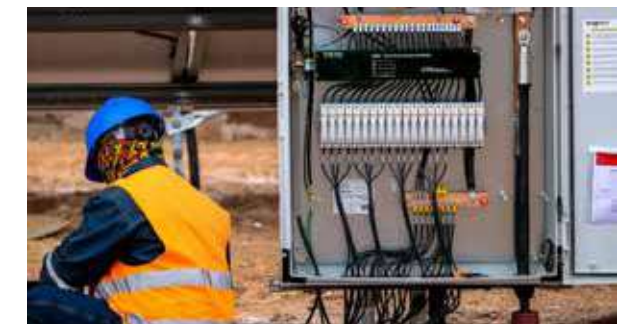
Figura 22: instalación de un sistema de valorización energética de los residuos agroindustriales por pirólisis dentro del proyecto Agrovalor, Costa de Marfil. Crédito: Pablo Ramos Roncal/AFD
