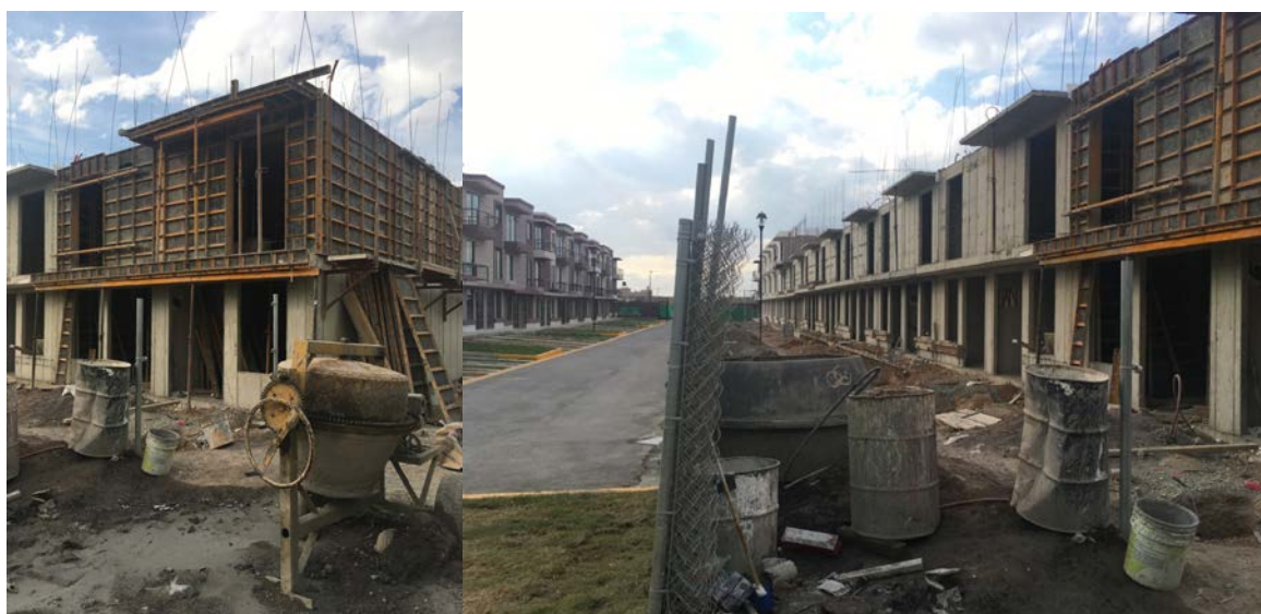
Figure 5 — Visite d'une impasse en construction : Rio Mira construit par Urbi, Tecámac
