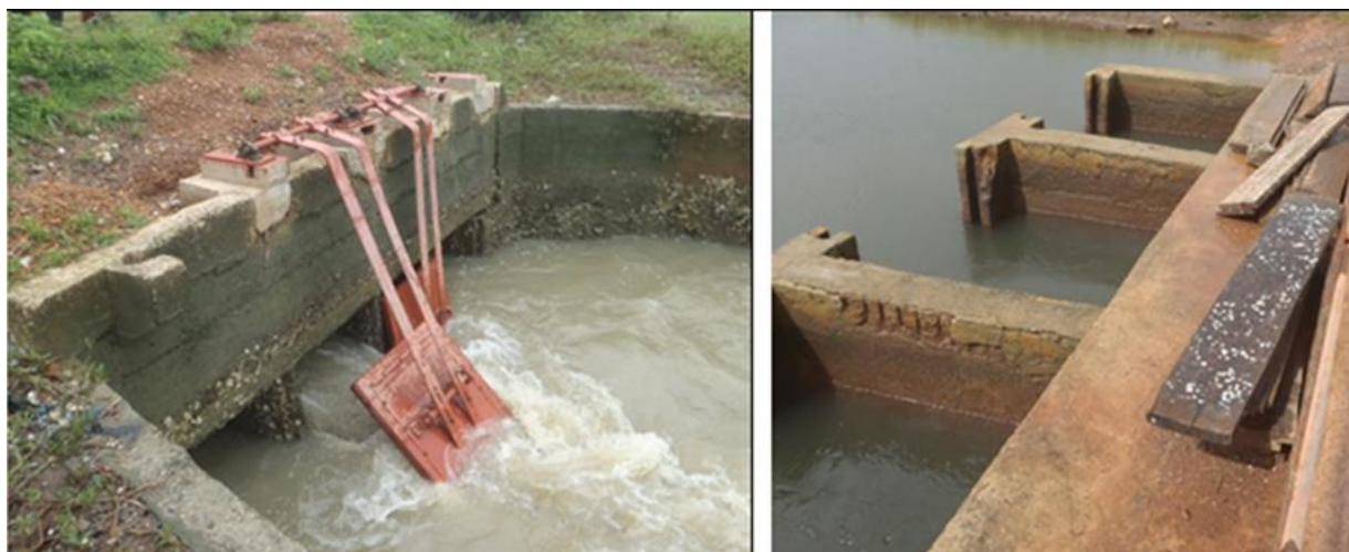
Figure 9 : Vanne à clapet et vannes à glissières ou batardeaux (Kondéyiré) 26
