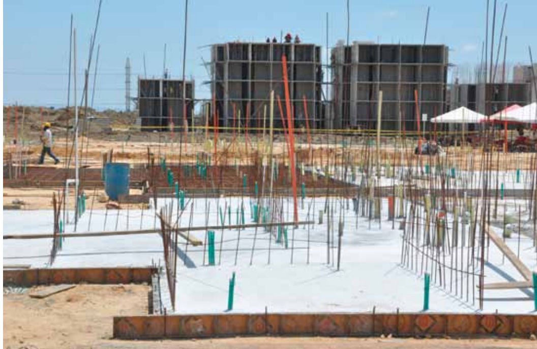
Construction de logements à Barranquilla, Colombie.
