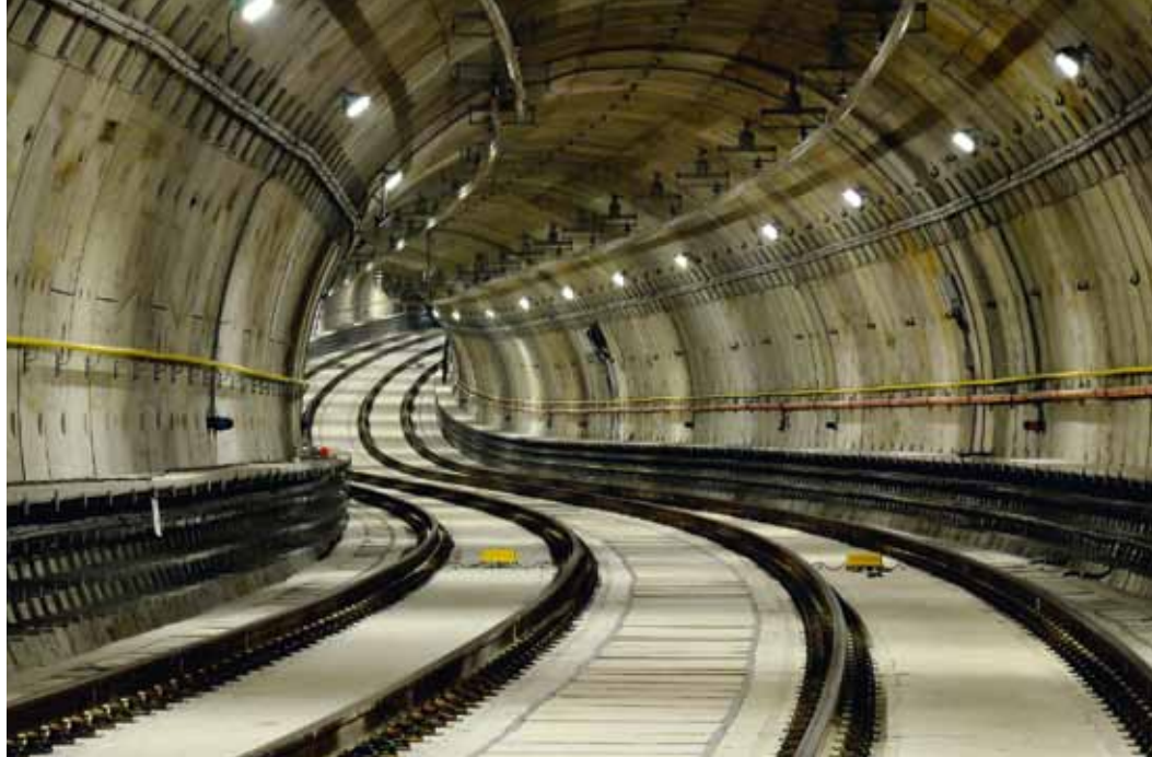
Les rails du métro de la nouvelle ligne n°4 de São Paulo, Brésil.
